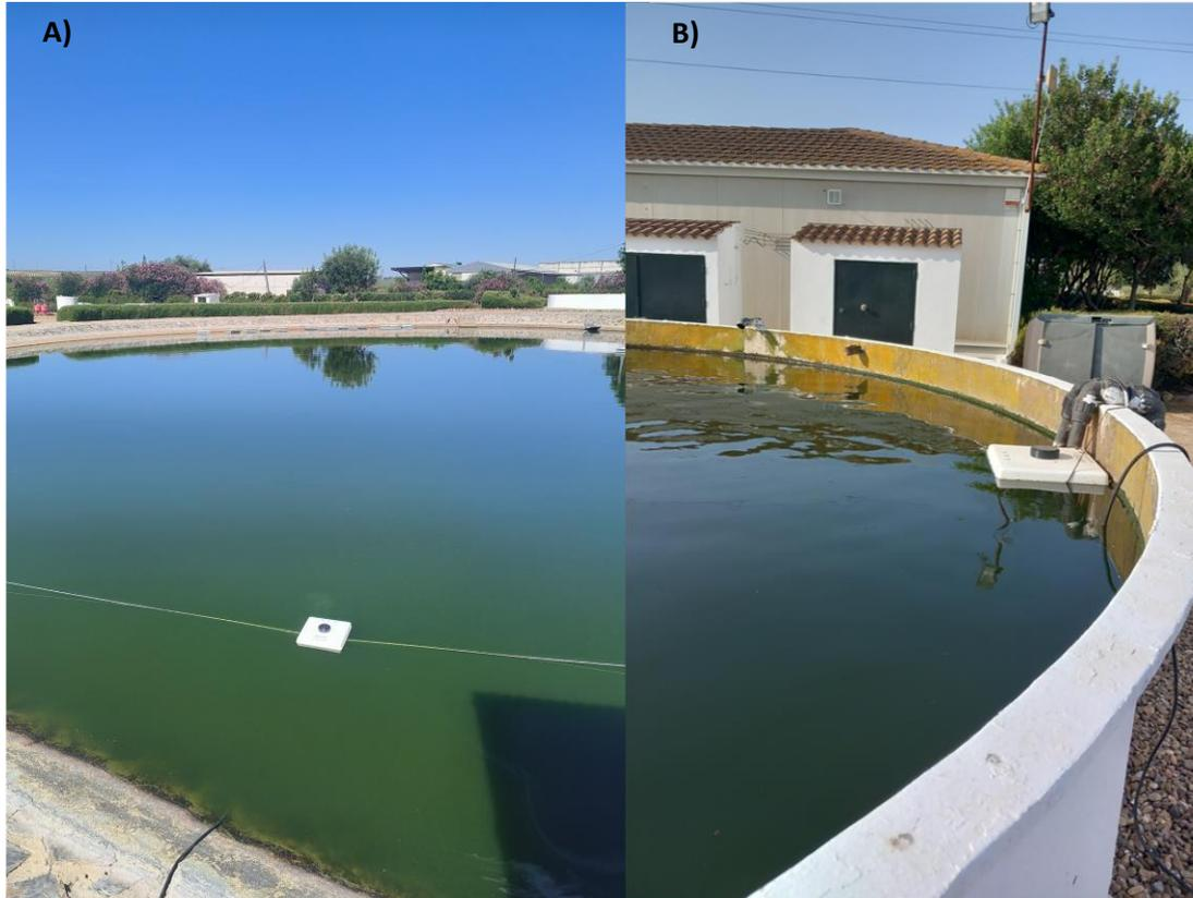
Implementación de equipo de ultrasonidos en: A) laguna de almacenamiento de agua para riego; B) en tanque de almacenamiento, CENTA
